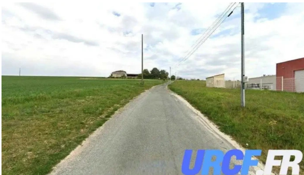
Pannetier construction chaniers
