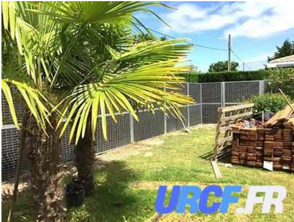
Mur anti bruit fabrication et installation fermisol photos du proprietaire
