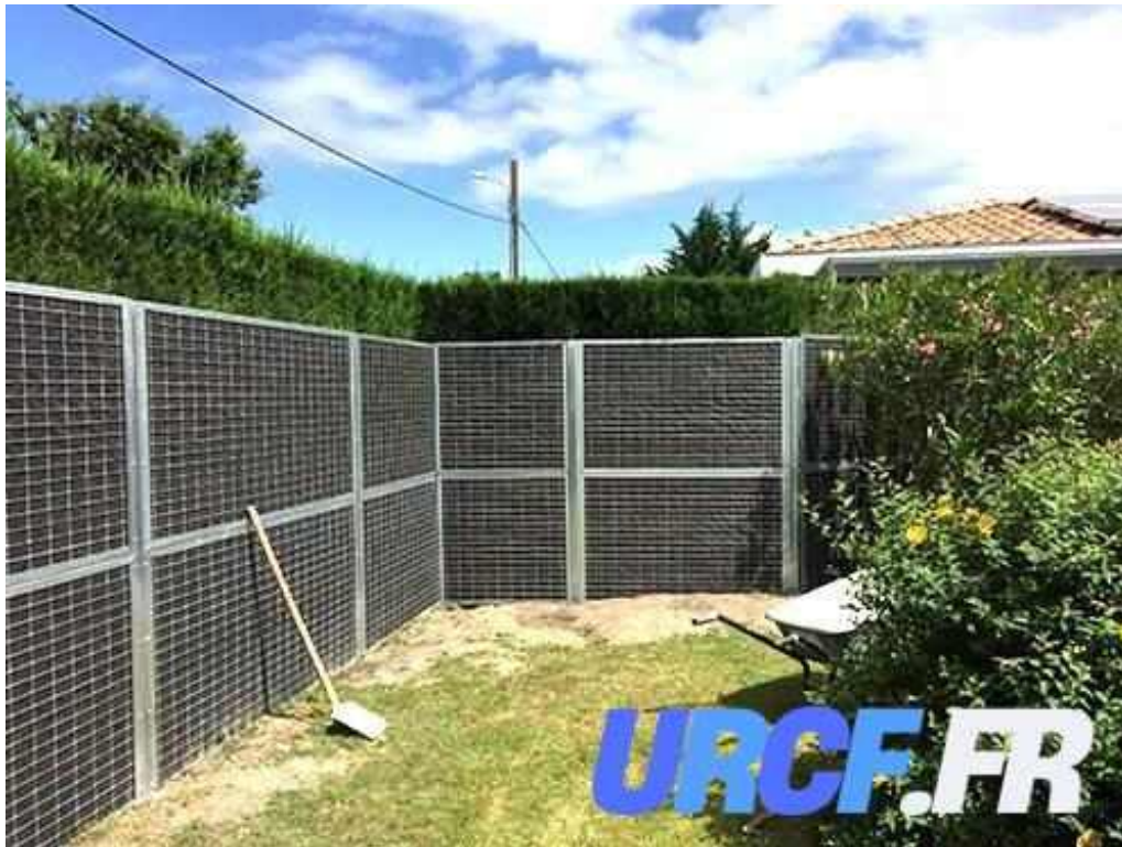
Mur anti bruit fabrication et installation fermisol artigues pres bordeaux
